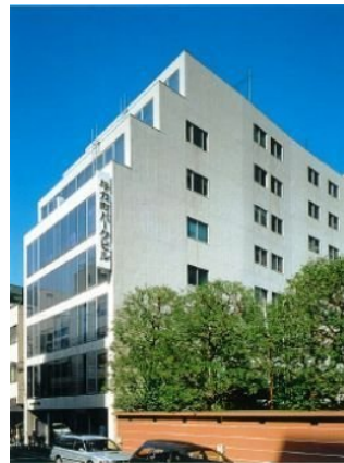
弊社ビル外観
