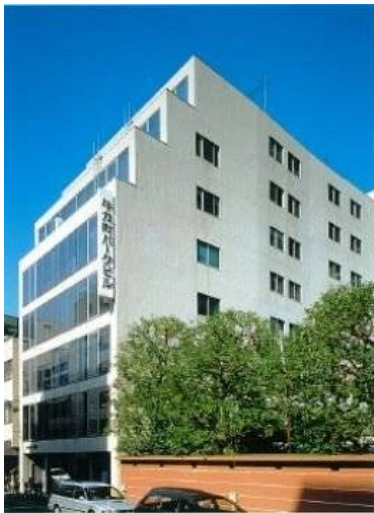
弊社ビル外観
